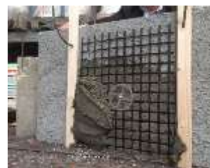
Copertura della rete e del connettore con la malta WELL REP 38/39
